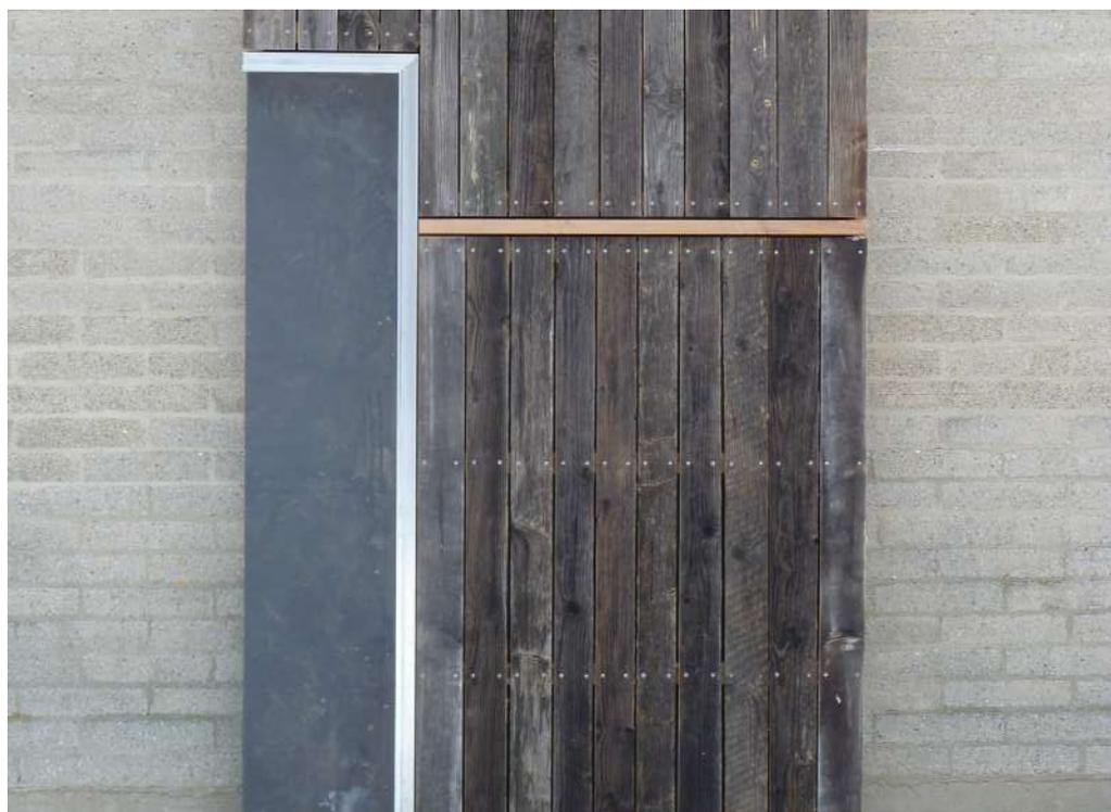
La suite du cahier des charges décrit également les critères de réception (bois nettoyé, découpé, raboté et entreposé proprement), les modalités de traitement pour assurer la résistance au feu et les modalités de pose en conformité au dessin prévu par les architectes.
