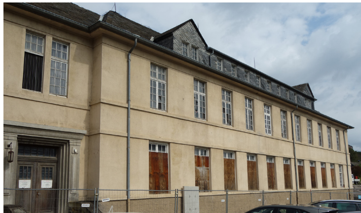
Photo extérieure du bâtiment - Wiltz © Rotor
