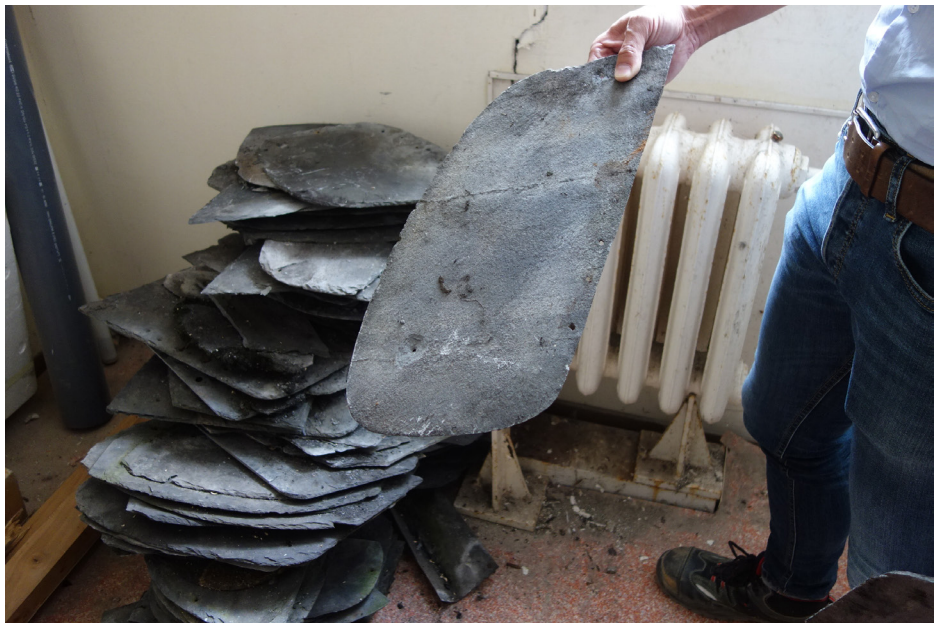
Relevé des matériaux potentiellement réutilisables : tuiles en ardoise - Wiltz © Rotor
