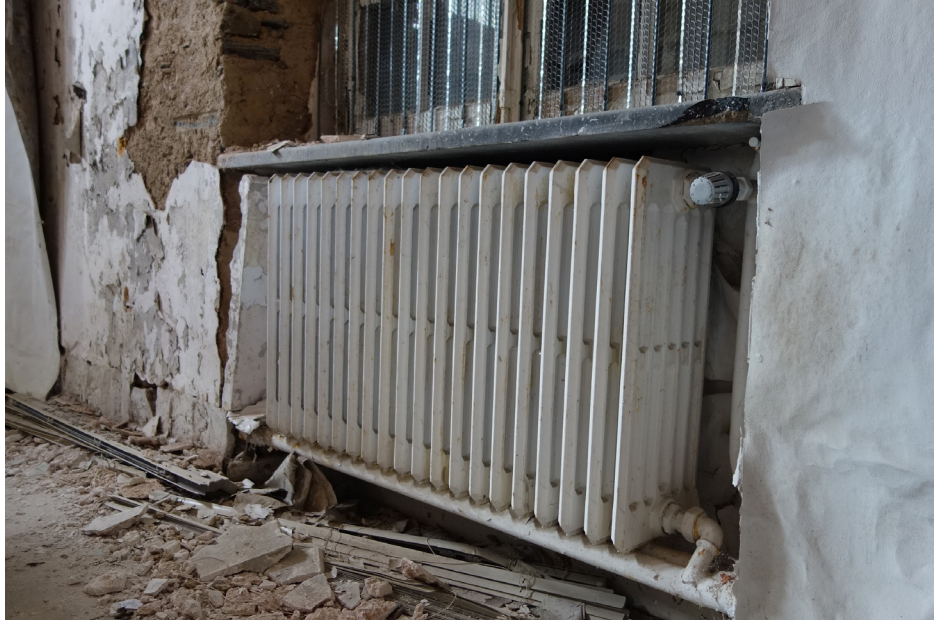
Relevé des matériaux potentiellement réutilisables : radiateur en fonte - Wiltz ©
