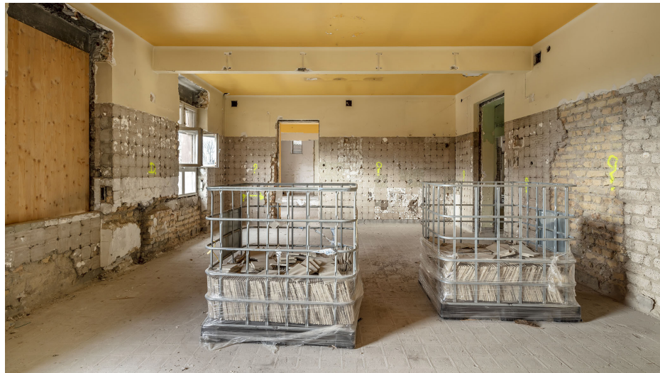
Carrelages démontés et conditionnés pour le transport © Luc Boegly
